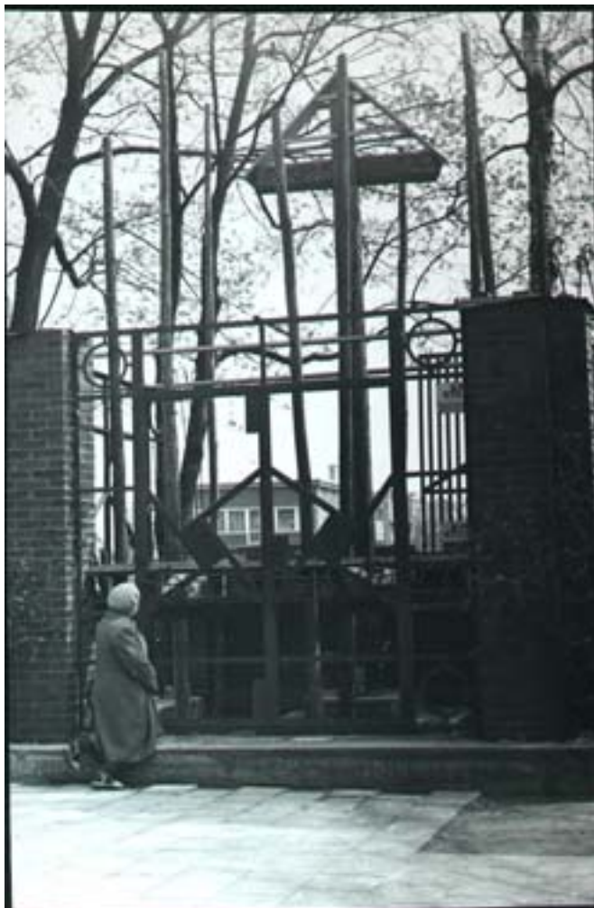
Kaplica krzyża w budowie-1988.
