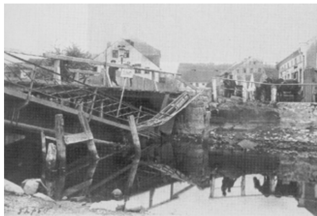
Zniszczony most na ulicy Grunwaldzkiej
