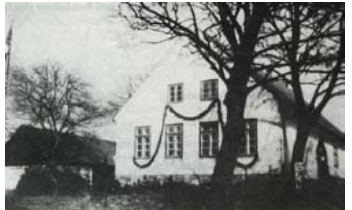
Szkoła w Zawadach - 1938
