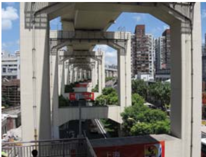
Część nadziemna szanghajskiego metra.
